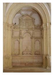
Obra do Arquiteto Filipe Terzi, este lavabo faz parte da "Grande Obra das Fontes" onde se inclui o Aqueduto concluído em 1620. Assinala-se aqui este lavabo do piso zero do Claustro Principal, porque ao contrário dos outros existentes no Convento de Cristo, este e o do braço sul do Cruzeiro, eram alimentados por água canalizada do Aqueduto, enquanto os restantes tinham reservatórios que era preciso encher com água das cisternas.
