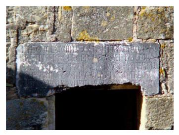
Elemento horizontal na parte superior do vão de janela ou porta que suporta a carga da parede. Porque há lintéis muito especiais, aqui se mostra e
